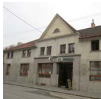
budovy dvou navštívených zařízení
