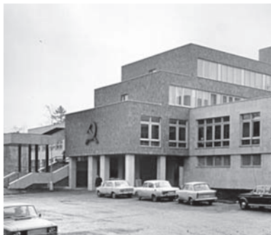
Pohled na budovu před rekonstrukcí
