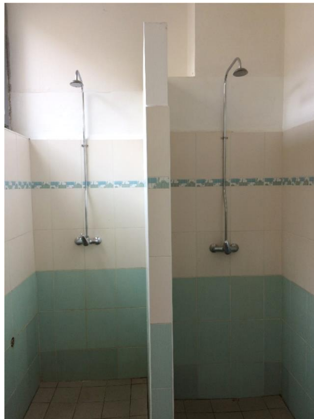
Obr. č. 3: Výměna flexibilních sprchových hadic za fixní
