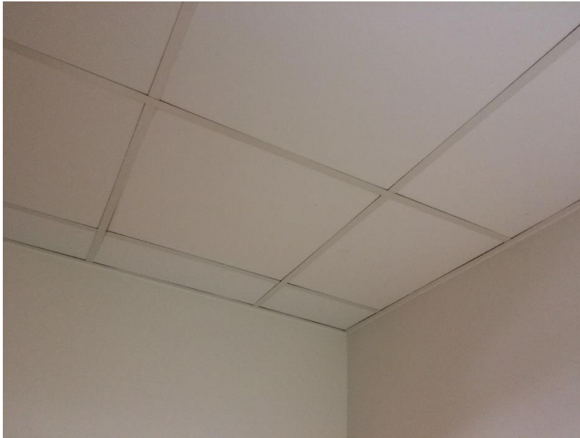
Obr. č. 2: Oprava poškozených podhledů na všech stanicích kliniky
