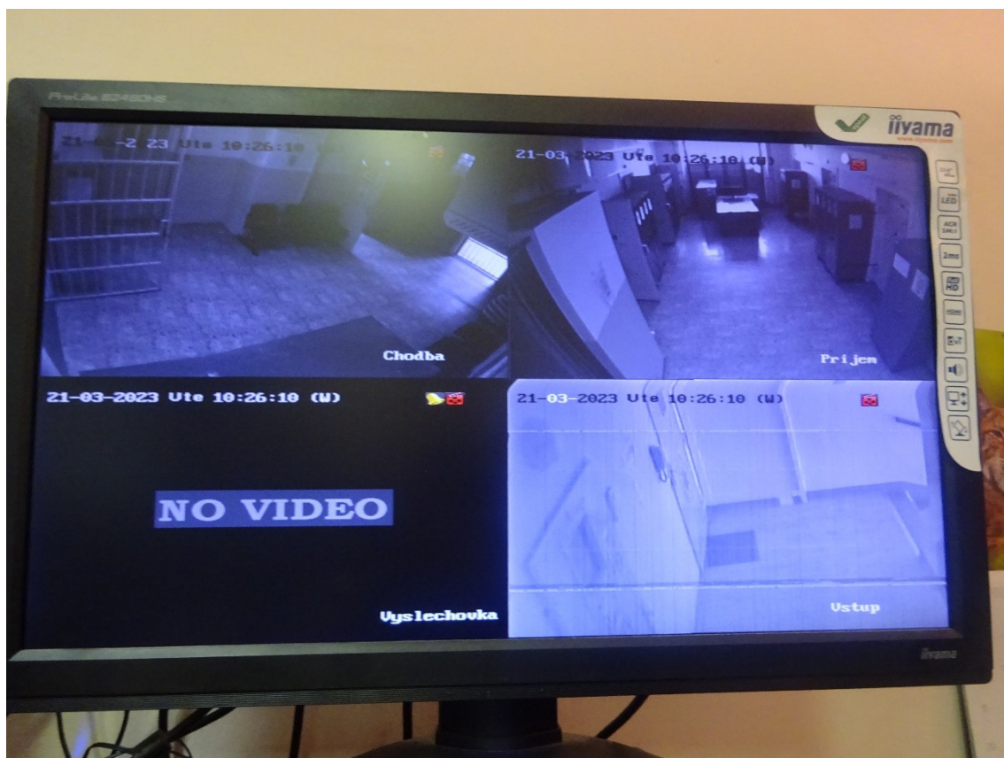
Foto č. 1: Výstup z kamer na dozorčím stanovišti, na výstupu „Prijem“ jde vidět část sprchového koutu.
