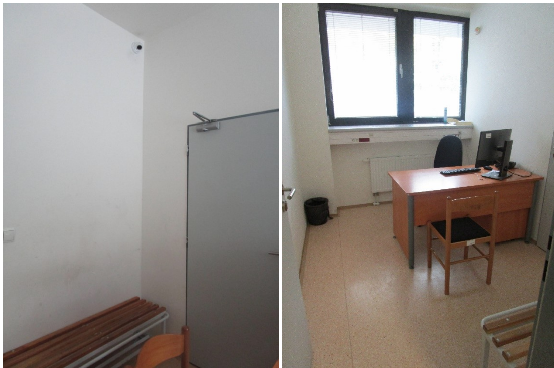
Foto č. 1 a 2: Kamerový systém ve výslechové místnosti č. 1.
