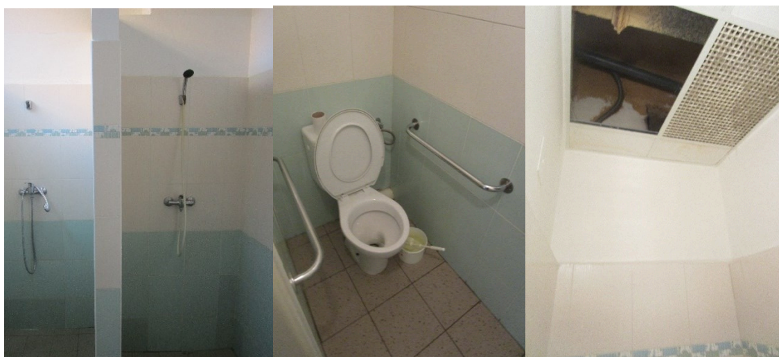
Obrázek 3: Poškozené podhledy
