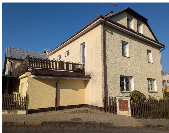
Obr. 1 Hlavní budova zařízení z ulice
