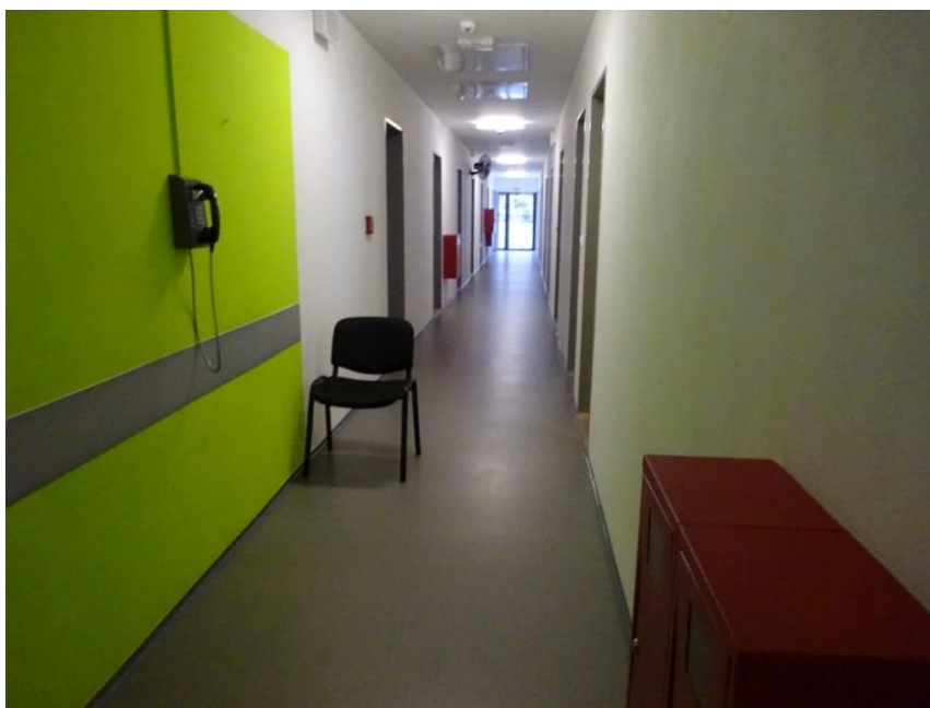
Telefonní automat v chodbě budovy C 1.
