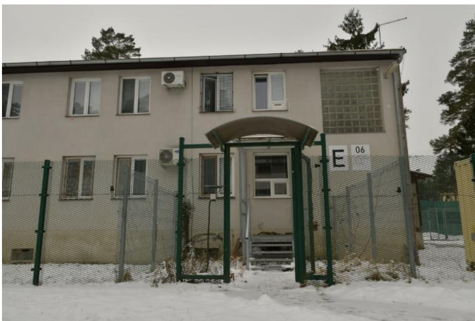
Branka k tzv. NON-STOPu z prostoru budovy C.
