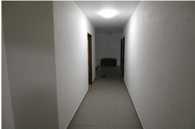
Obrázek 7: Chodba v zařízení – chybějící madla
