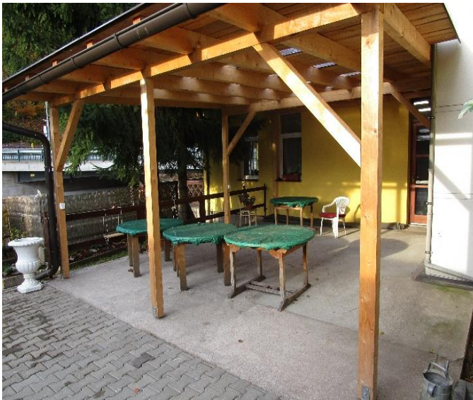
Obrázek 2: Přístřešek na dvorku
