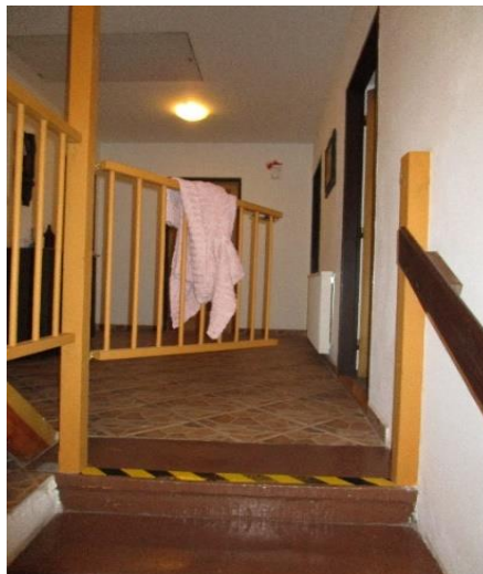
Obrázek 8: Branka nad schodištěm
