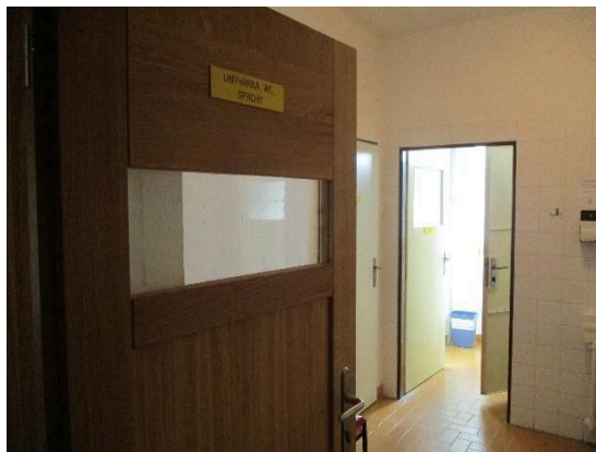
Obrázek 6: Průzory ve dveřích umývárny a toalet
