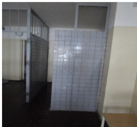
Obr. 3: Sanitární zařízení oddělené zídkou
