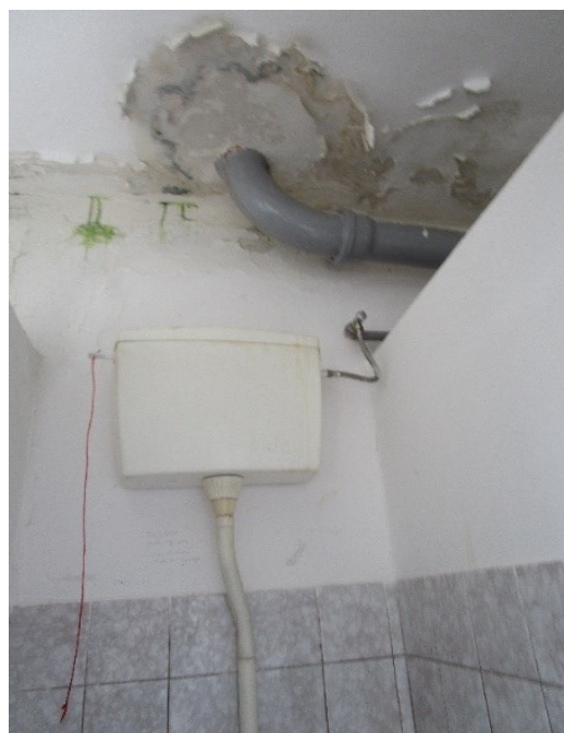
Obr. 10: Plíseň na toaletách
