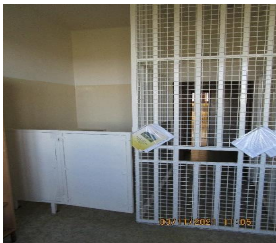
Přepážka mezi ubytovací místností a toaletou
