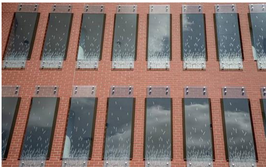
Okna z JINÉHO zařízení; technické řešení zvolené na psychiatrii Fakultní nemocnice Ostrava
