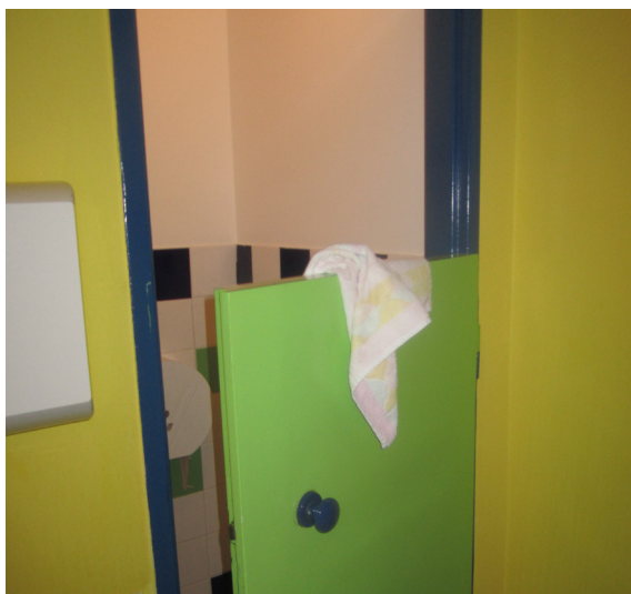
Zkrácené dveře na toaletě
