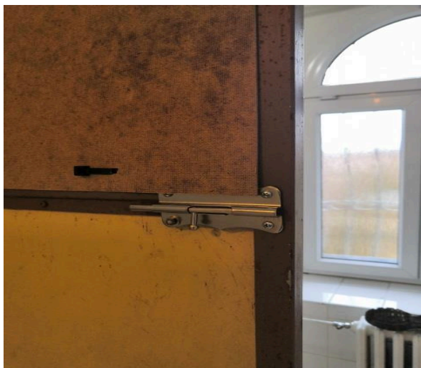
Příloha 5 – zakrytí dveří a instalace zamykacích mechanismů
