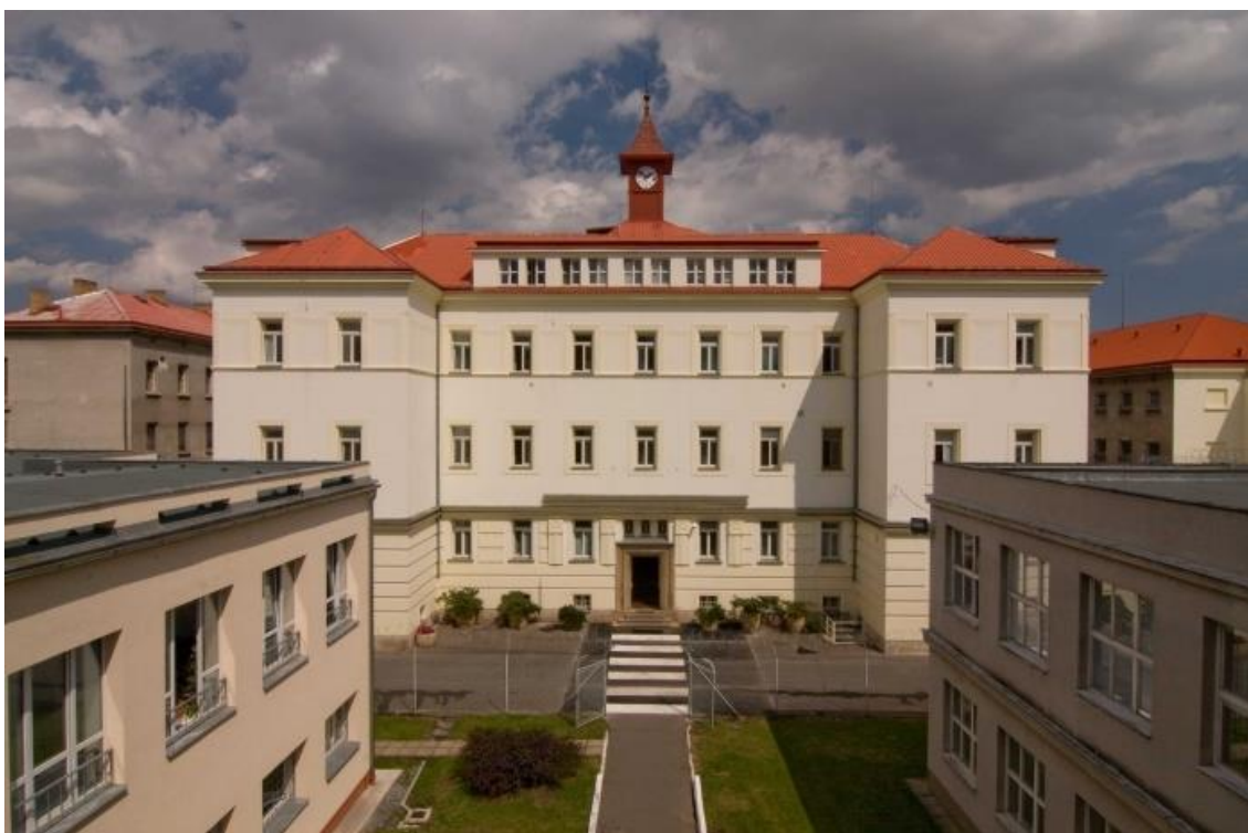
Fotografie č. 1: Pohled na hlavní vstup do Vazební věznice Praha-Pankrác. 12
