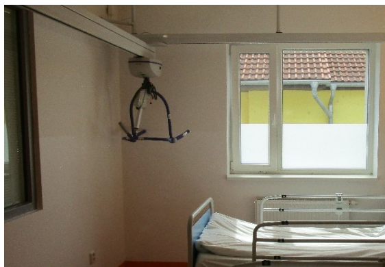
Obrázek 11 - závěsný zvedací systém na stanici 10
