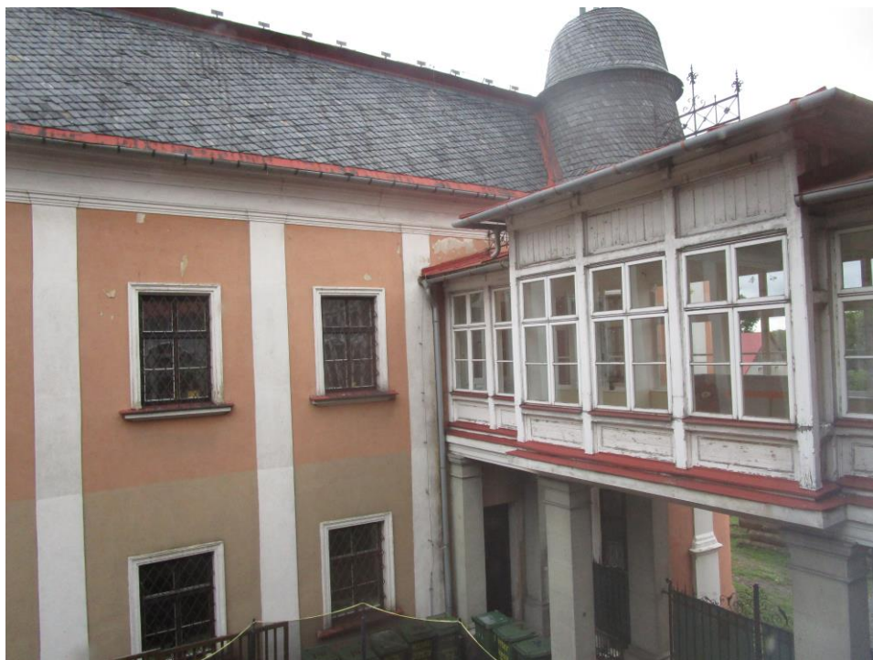
Obr. 7 – Atrium a břidlicová střecha zařízení.
