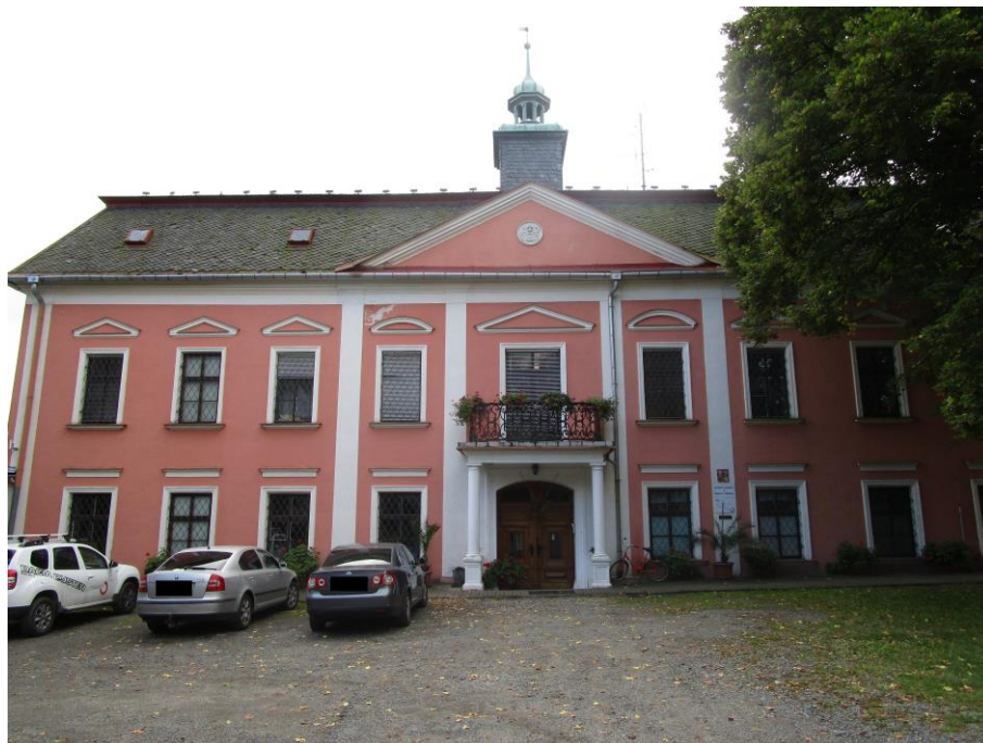
Obr. 5. – Přední strana budovy zařízení s hlavním vstupem.
