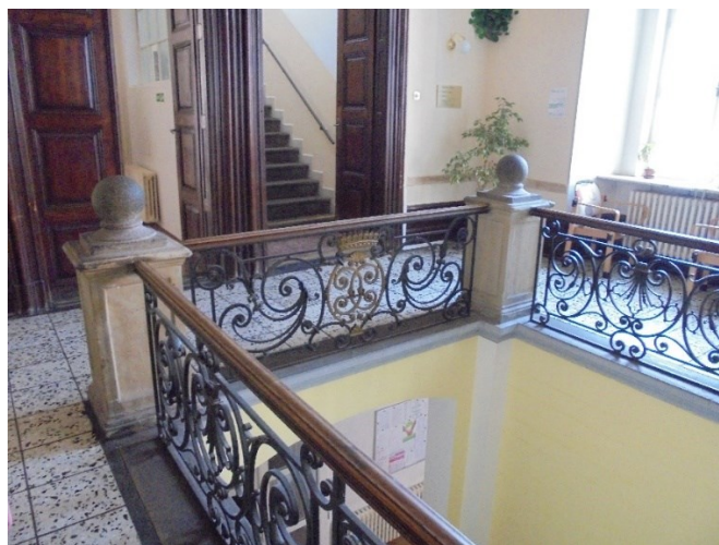
Obrázek 3: Zábradlí u schodiště na stanici muži 2
