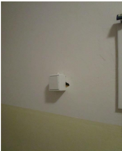
Obrázek 1 – Spínač na chodbě bez označení (fotografie ze systematické návštěvy).
