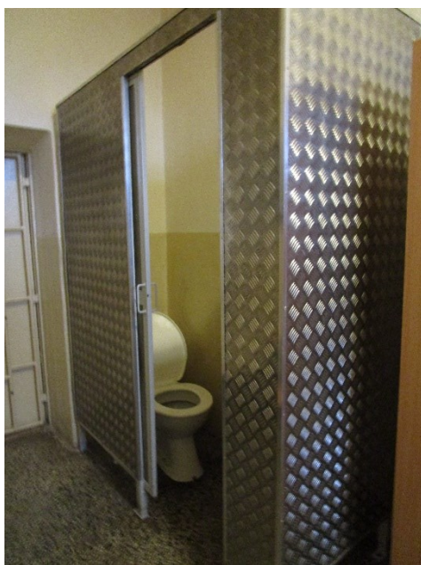
Obrázek č. 13: Oddělení toalety od zbytku cely
