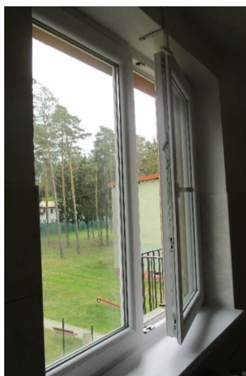
Obrázky 9 a 10 – Zarážky v okně a v balkonových dveřích
