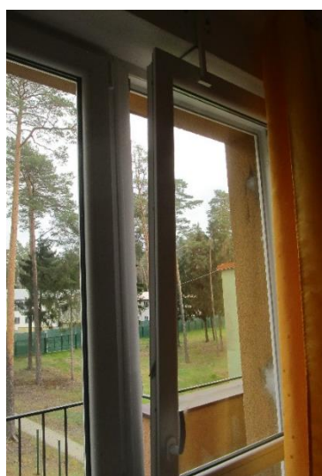
Obrázky 9 a 10 – Zarážky v okně a v balkonových dveřích
