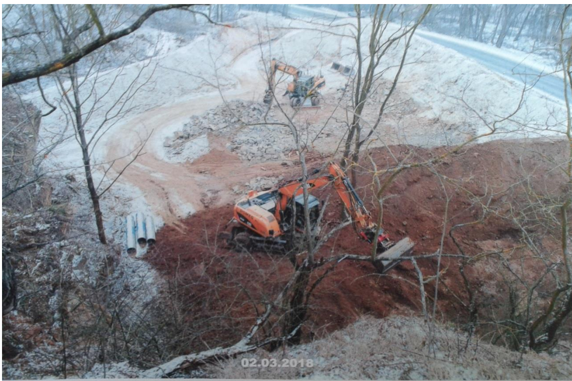
Foto č. 2 – zemní práce v dotčené lokalitě v k. ú. Z, foto ze spisu stavebního úřadu.
