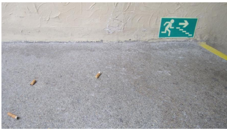
Obr. č. 4: Schodiště před vstupem na odd. A16
