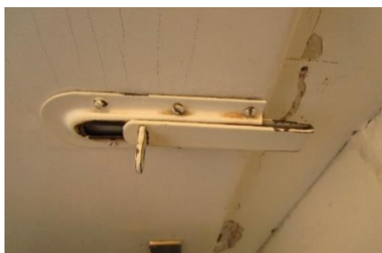
Obr. 12 - Nefunkční zámek na dveřích toalety 6. rodinné skupiny, budova Na Návrší
