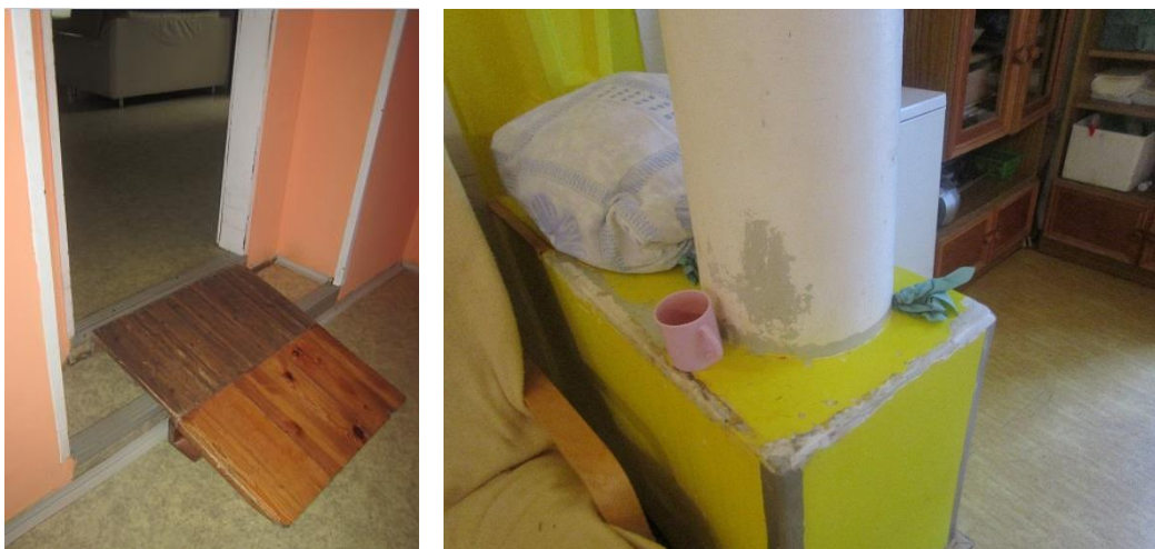
Obrázek č. 5 a 6: Úrovně nerovnost na chodbě v 2. patře; narušené povrchy ve velkém sále
